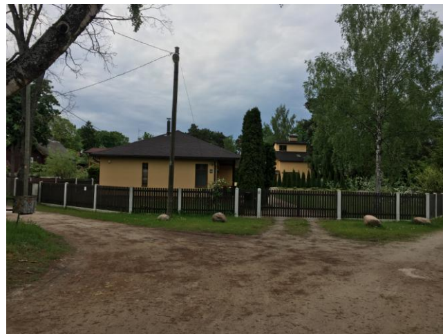
Attēls nr. 14. Esošā apbūve zemesgabalā Kaugurciema iela 14, Jūrmala
