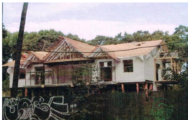
15.attēls. Būvniecības process. Jaunā apbūve celta no gāzbetona un apšūta ar koku.
