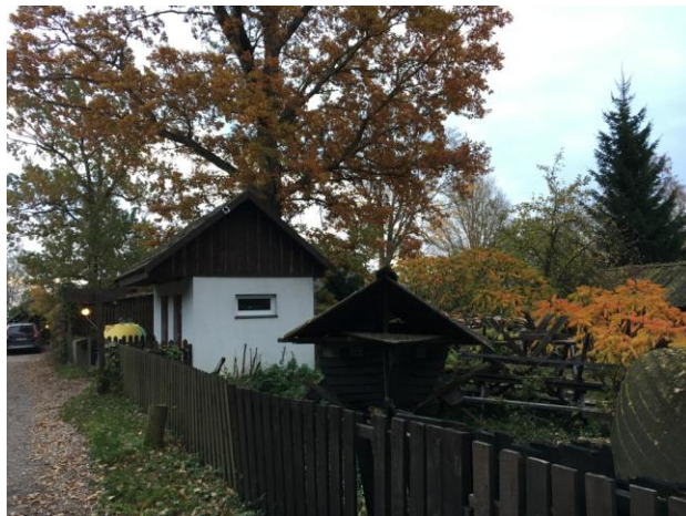
6.attēls. Esošā apbūve
