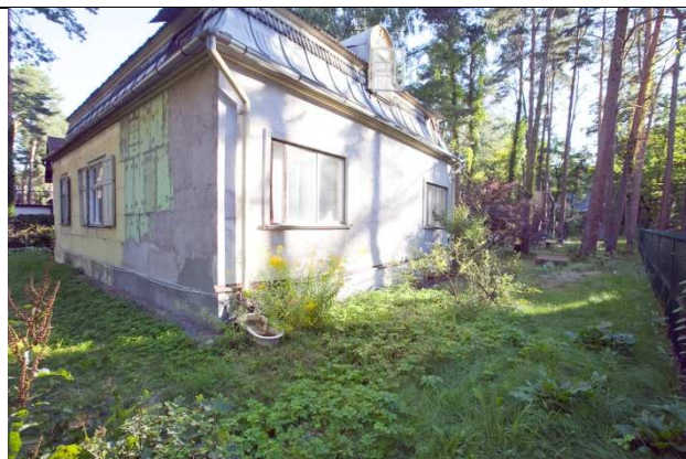
Ēkas pagalma fasāde (dienvidu daļā), vietām tā ir padomju laikā siltināta, daļēji apmesta
