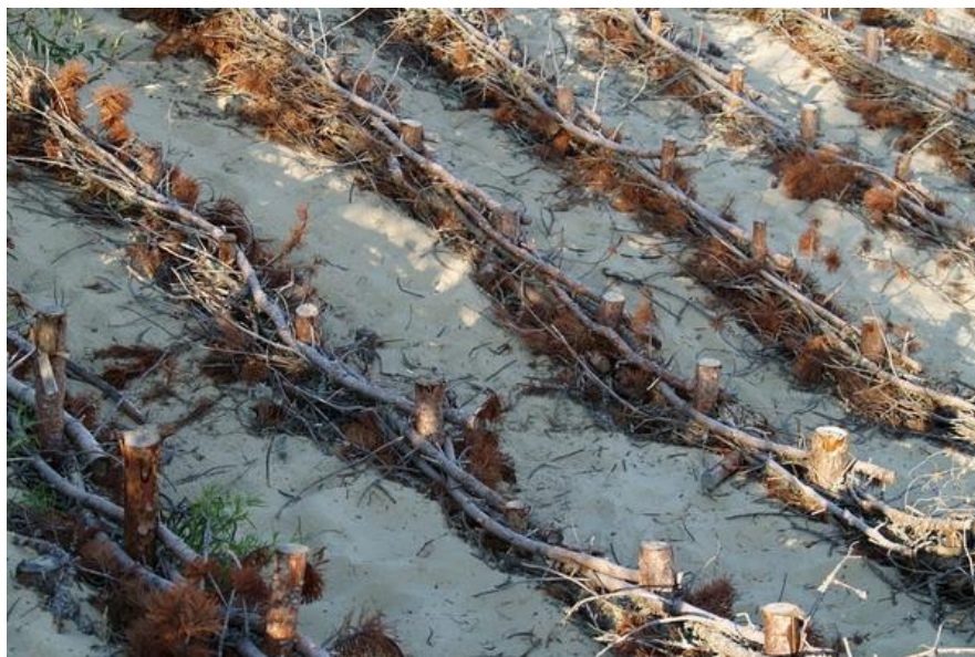
35.attēls. Piemērs Priekškāpas stiprināšanai ar kārklu zaru pinumu.
