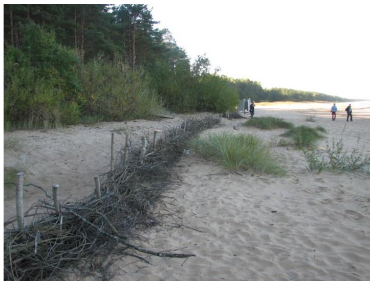
34.attēls. Piemērs Priekškāpas stiprināšanai ar kārkļu zaru pinumu.
