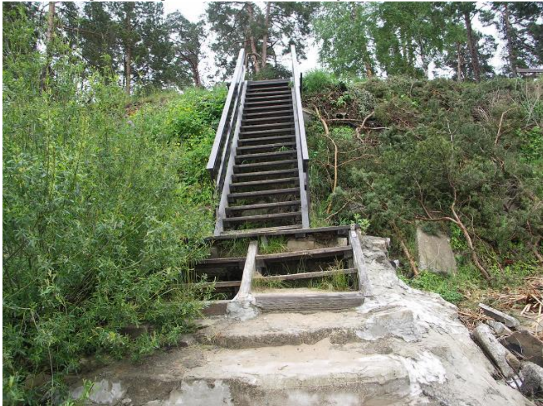
2. attēls. Kāpnes mazina krasta eroziju. To kavē arī samestie zari un betona gabali krasta piekāvē.
