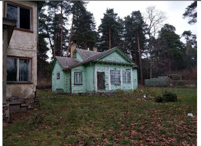
Esošā apbūve Gaujas ielā 1, lit.002
