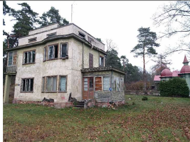
Esošā apbūve Gaujas ielā 1, lit.001.
