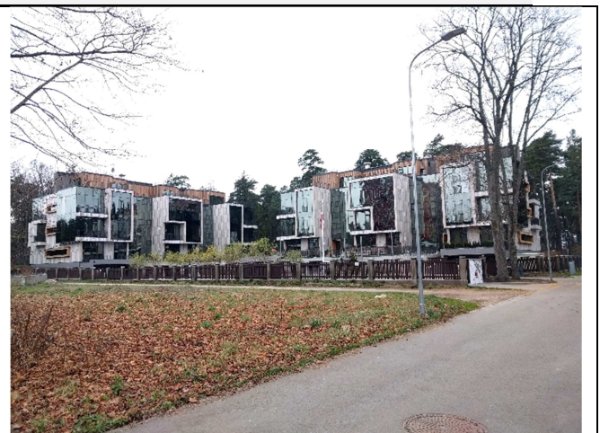
Jaunā apbūve Gaujas ielā 2 un Gaujas ielā 4
