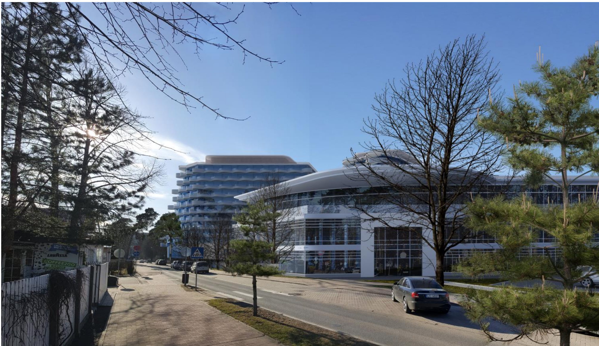
Attēls 24. Skats no Tirgoņu ielas puses Jūras ielā (2).
