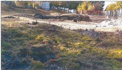
F - 07 BETONA PAMATU FRAGMENTĀS (DAĻĀ ZEM ZEMES. NAV KUSTINĀMS)
