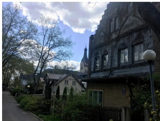
10.attēls. Skats uz detālplānojuma teritoriju – ēka ar kad.apz.13000102104001 un 13000102104002.
