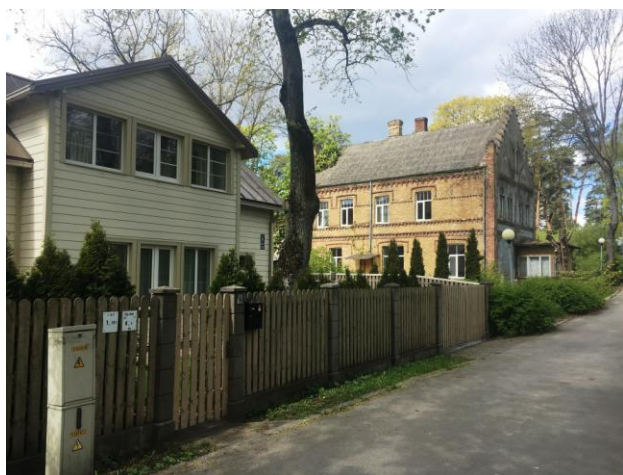
5.attēls. Skats uz detālplānojuma teritoriju – ēka ar kad.apz.13000102104002 un 13000102104001.
