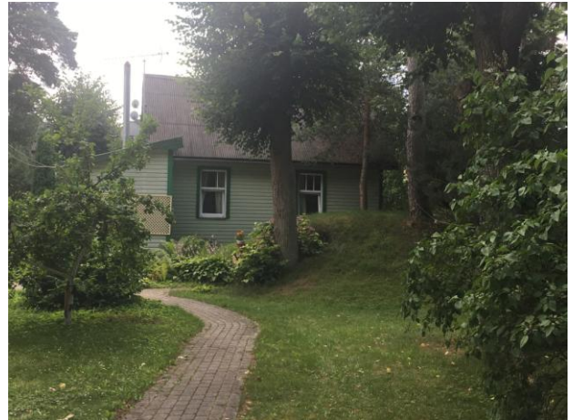
4.attēls. dzīvojamā ēka ar kadastra apzīmējumu 13000121202002.
