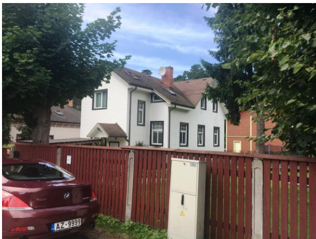
5.attēls. dzīvojamā ēka ar kadastra apzīmējumu 13000121202001.
