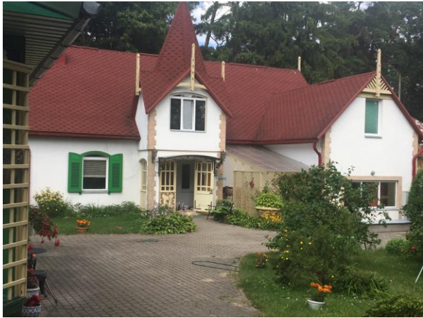
3.attēls. dzīvojamā ēka ar kadastra apzīmējumu 13000121202004.
