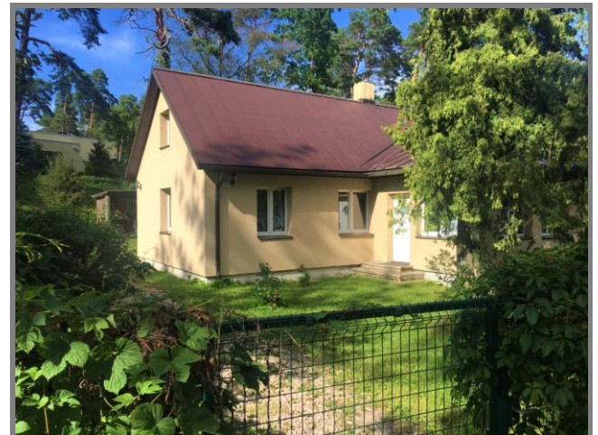
8.attēls. Skats uz detālpilānojuma teritoriju no Zaru ielas.
