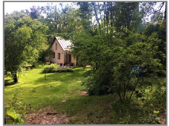
6.attēls. Skats uz detālpilānojuma teritorijā esošo apbūvi.
