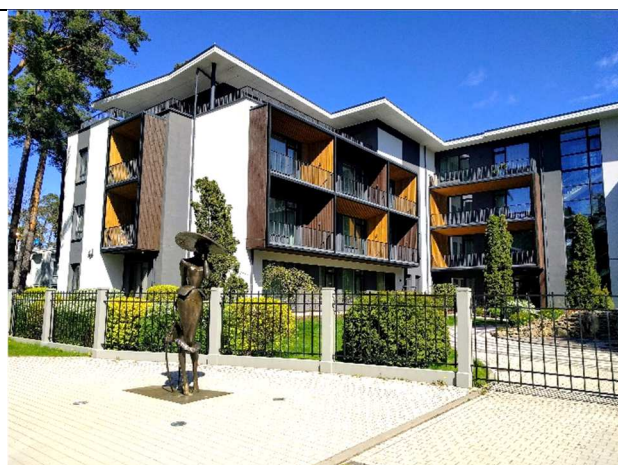
Esošais labiekārtojums Turaidas ielā
