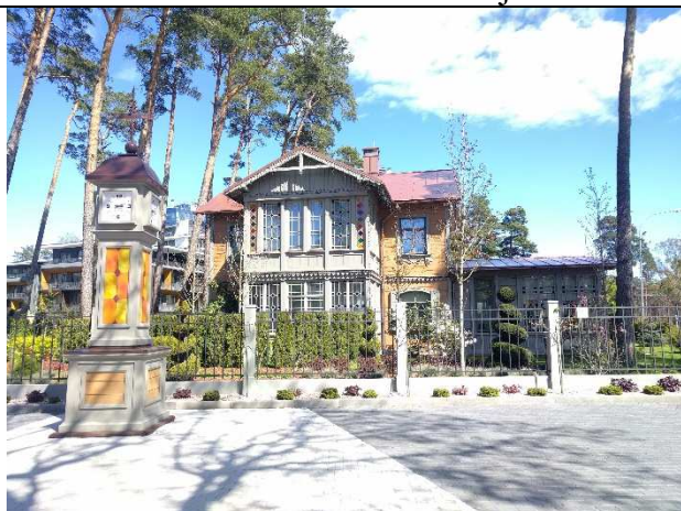
Esošā rekonstruētā ēka, skats no Turaidas ielas
