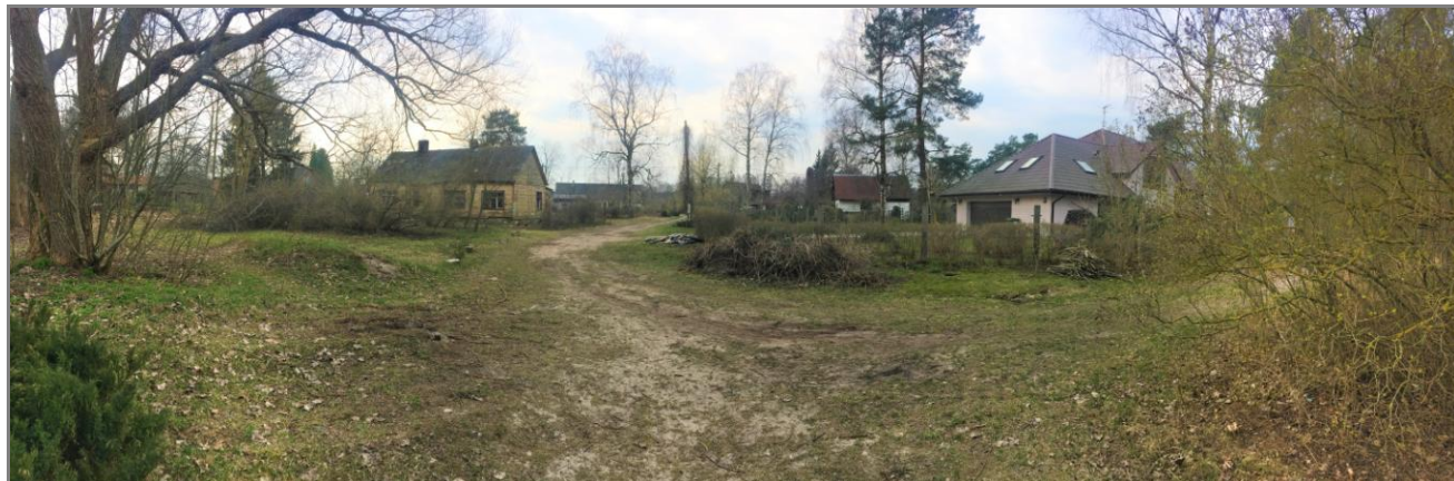
4.attēls. Skats no jūras puses uz detālpārplānojuma teritoriju (kreisajā pusē) un blakus esošo apbūvi (labajā pusē) – ēka ar kadastra apzīm. 1300 019 1306 001 Kaugurciema ielā 69A, ēka ar kadastra apzīm. 1300 019 1307 001 Kaugurciema ielā 69.
