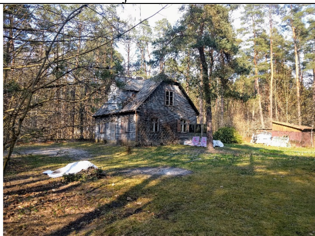
Esošā apbūve Cīruļu ielā 18, skats no pagalma teritorijas
