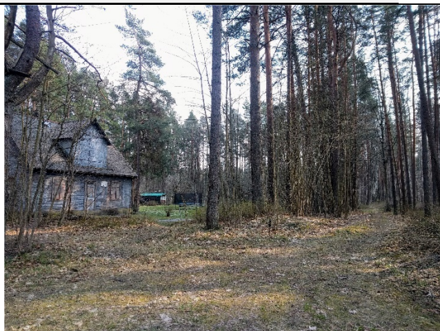
Esošā ēka Cīruļu ielā 18, detālplānojuma teritorijas rietumu robeža
