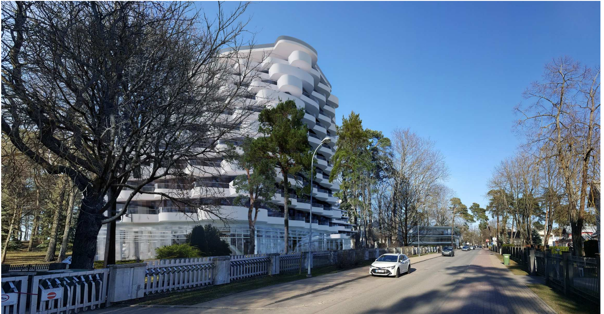
Attēls 29. Skats no Ērgļu ielas puses Jūras ielā (atbilstoši shēmai Attēlā 22. skats Nr.7).
