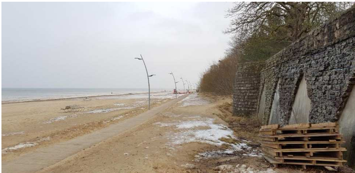
Attēls 19. Pludmalē 2015. g. izbūvētā koka pastaigu laipa ar apgaismojumu (850 m garumā ierīkota pludmales posmā no Turaidas ielas līdz Tirgoņu ielai) (02.2019.).
