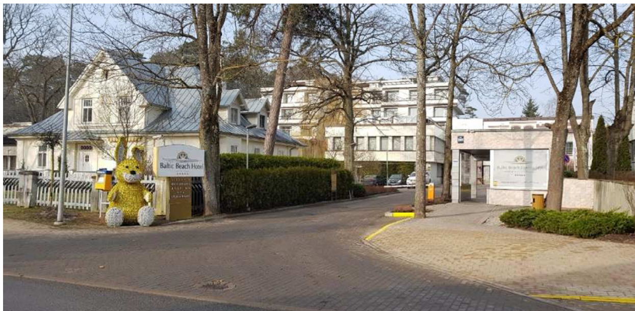
Attēls 15. Galvenā transporta līdzekļu iebrauktuve “Baltic Beach Hotel” teritorijā – skats no Jūras ielas (02.2019.).
