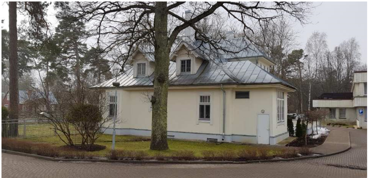
Attēls 7. Ēka ar kad. apz. 1300 009 1405 001. Skats no galvenā iebrauktuves "Baltic Beach Hotel" teritorijā (02.2019.).
