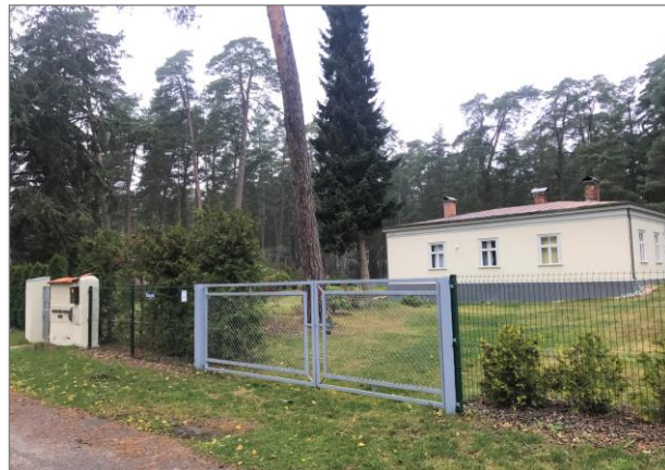
8.attēls. Skats uz detālplānojuma teritoriju un iebrauktuvi detālplānojuma teritorijā.
