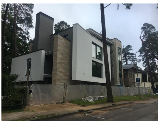
36.attēls Būvniecības stadijā esošā 3 stāvu apbūve Dzintaru prospektā 4.
