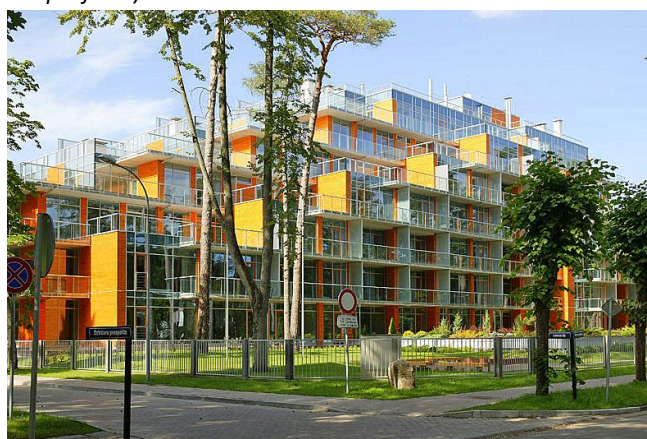
39.attēls. Esoša 8 stāvu apbūve Dzintaru prospektā 13/15 (2004.gadā saskaņot būvprojekts Nr.536, 2007.gadā ēka nodota ekspluatācijā).
