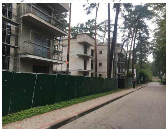
37.attēls. Būvniecības stadijā esošā 3 stāvu apbūve Dzintaru prospektā 12 (18.03.2016. gadā saskaņot būvprojekts).
