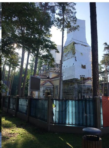
42.attēls. Dzintaru pareizticīgās baznīcas būvniecības process. Zemesgabals Turaidas iela 11.
