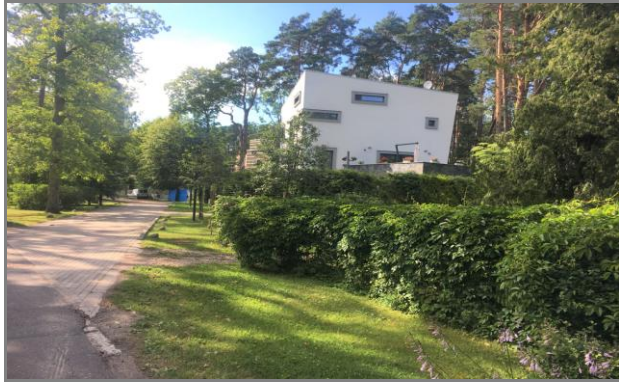
3.attēls. Blakus esošā apbūve zemesgabālā Kāpu ielā 55A.
