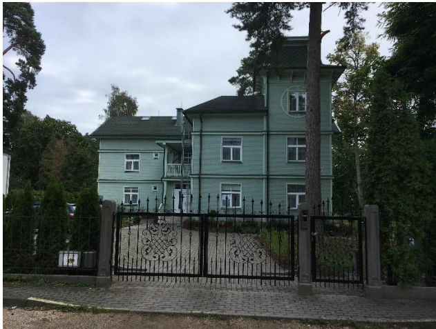
4.attēls. Ēka ar kadastra apzīmējumu 13000091803001 skatā no Kaudzišu ielas.
