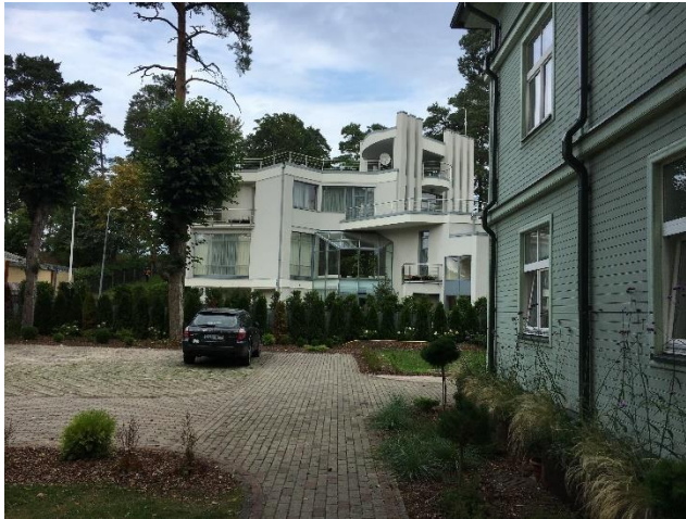
6.attēls. Ēka ar kadastra apzīmējumu 13000091803002. Skats uz ēkas dienvidu fasādi.
