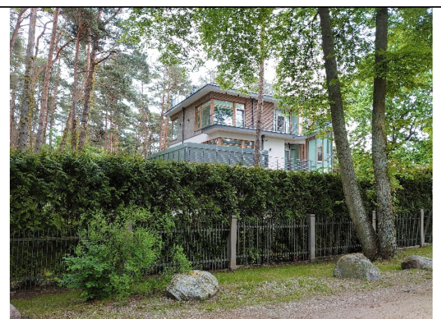
Apbūve Puķu ielā 1
