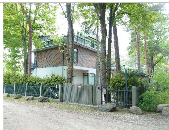
Apbūve Puķu ielā 2
