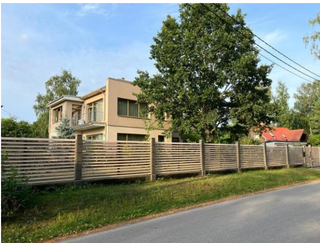
13. attēls. Sēkļu ielā 2 k-1 esošā apbūve.
