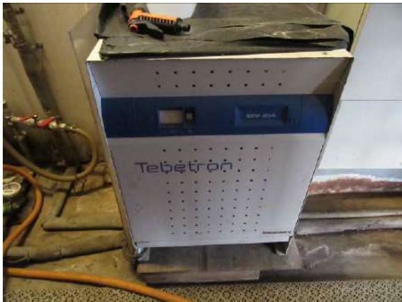
Ledus tīrīšanas mašīna akumulatoru lādētājs – D80/90 B-FT 320A
