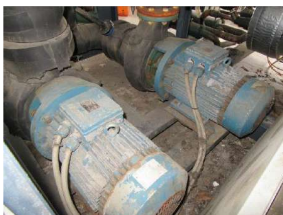
Ledus saldēšanas iekārtas cirkulācijas sūkņi – Calpeda NM/100/200EE (44311.002)
