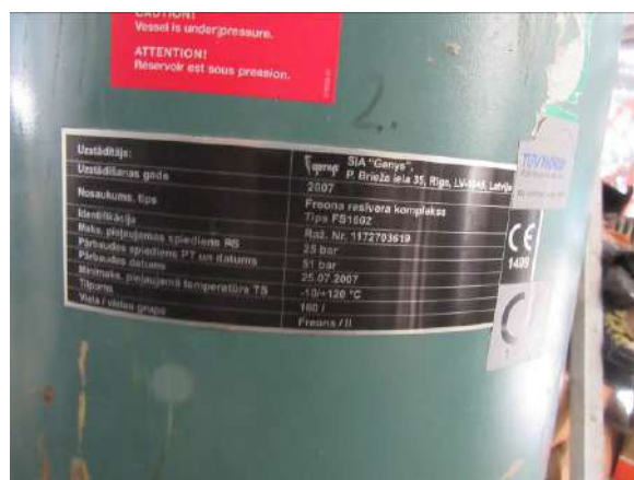
Ledus saldēšanas iekārta – Freona resīvera komplekss FS1602 (44311.002)
