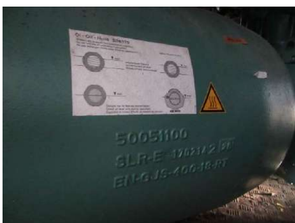
Ledus saldēšanas iekārtas kompresors Nr. 2 – CSH 8573-140 (44311.002)
