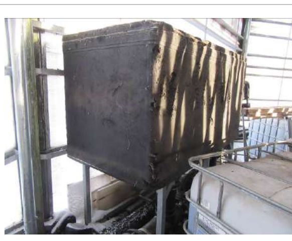
Ledus saldēšanas iekārtas apsaistes aprīkojums – saldēšanas šķidrums trauks (44311.002)
