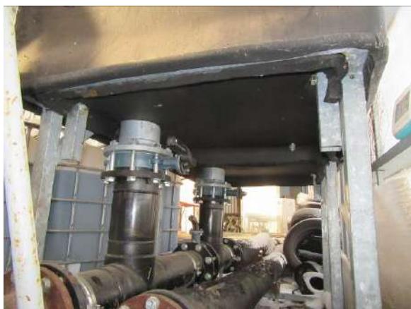
Ledus saldēšanas iekārtas aprīkojums – antifīrīza trauka apsaiste
