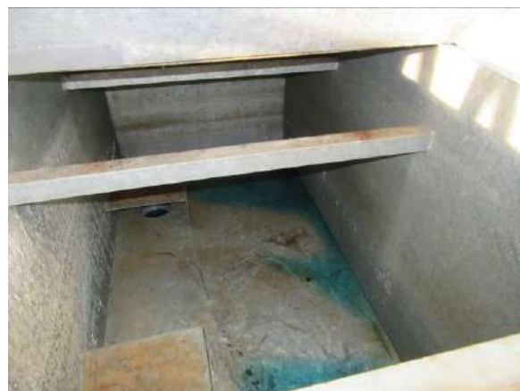
Ledus saldēšanas iekārtas apsaistes aprīkojums – antifīrīza trauks
