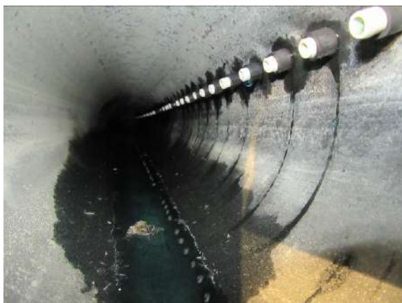
Ledus saldēšanas iekārtas aprīkojums – saldēšanas šķidrums kanāls (44311.002)
