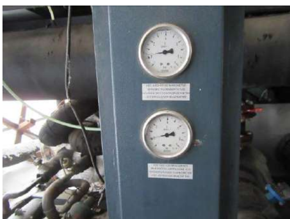
Ledus saldēšanas iekārtas H 2 O izlādes spiediena rādītāji (44311.002)
