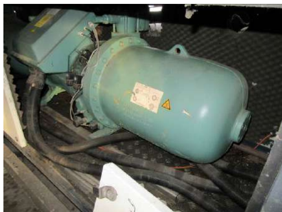
Ledus saldēšanas iekārtas kompresors Nr. 1 – CSH 8573-140 (44311.002)
