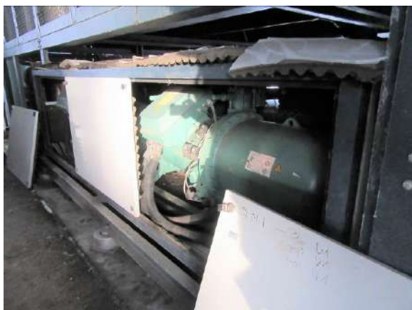
Ledus saldēšanas iekārtas kompresors Nr. 1 – CSH 8573-140 (44311.002)
