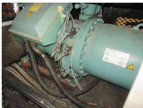
Ledus saldēšanas iekārtas kompresors Nr. 2 – CSH 8573-140 (44311.002)
