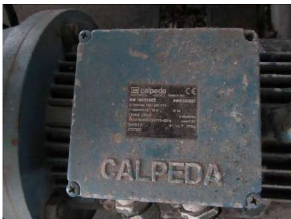
Ledus saldēšanas iekārtas cirkulācijas sūkņi – Calpeda NM/100/200EE (44311.002)
