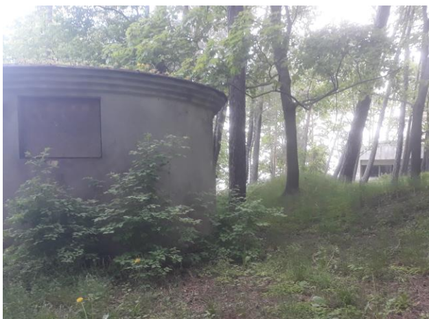
Attēls 16 Sūkņu stacijas ēka. Avots: METRUM.
