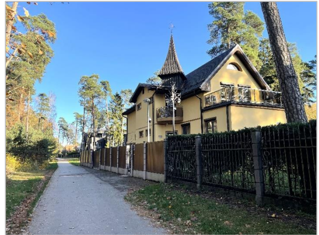
9. attēls. Detālplānojuma teritorijā esošā dzīvojamā māja ar kadastra apzīmējumu 1300 008 1203 002.
