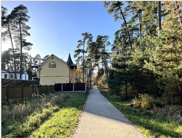
8. attēls. Detālplānojuma teritorijā esošā dzīvojamā māja ar kadastra apzīmējumu 1300 008 1203 002.
