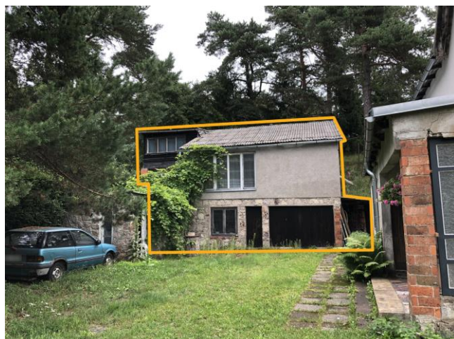
5.attēls. Saimniecības ēka Detālpilānojuma teritorijā
