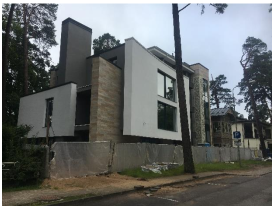
36.attēls Būvniecības stadijā esošā 3 stāvu apbūve Dzintaru prospektā 4.
