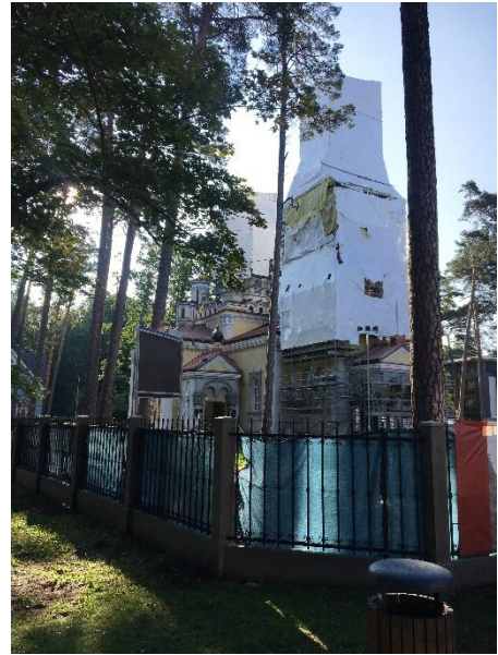
42.attēls. Dzintaru pareizticīgās baznīcas būvniecības process. Zemesgabals Turaidas iela 11.
