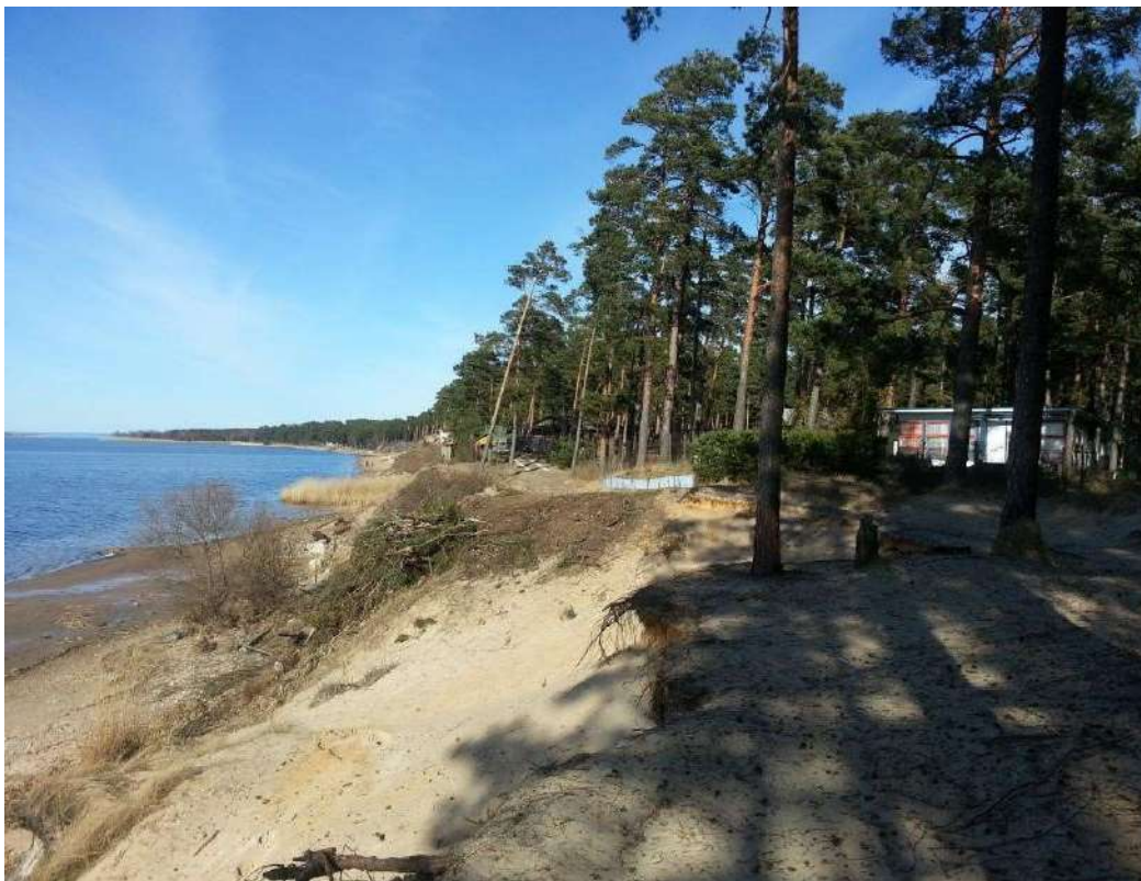
2.attēls. Lielupes krasta erozijas process
