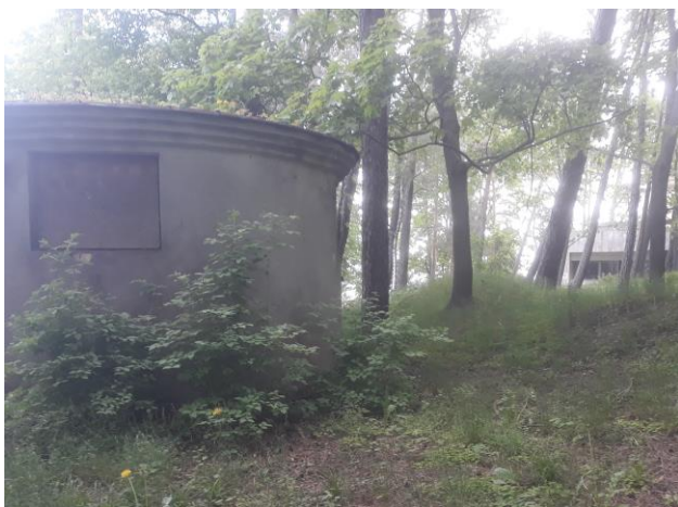
Attēls 16 Sūkņu stacijas ēka. Avots: METRUM.
