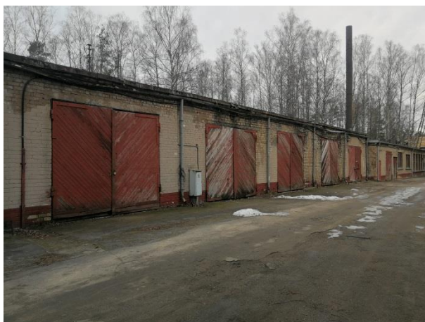
6. att. Garāža-katlu māja (1. tab. Nr. 2)
