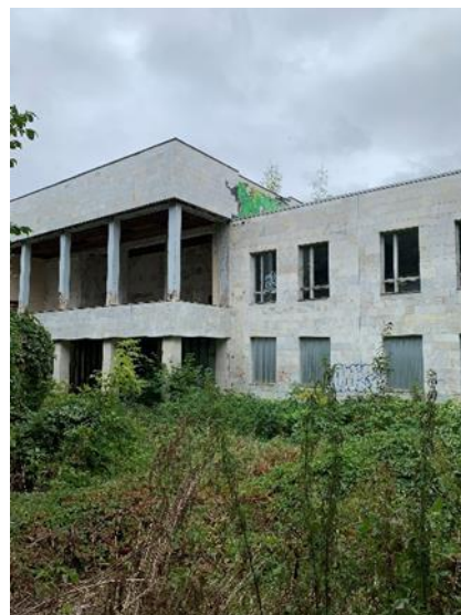
Attēls 19 Viesnīcas fasāde.
