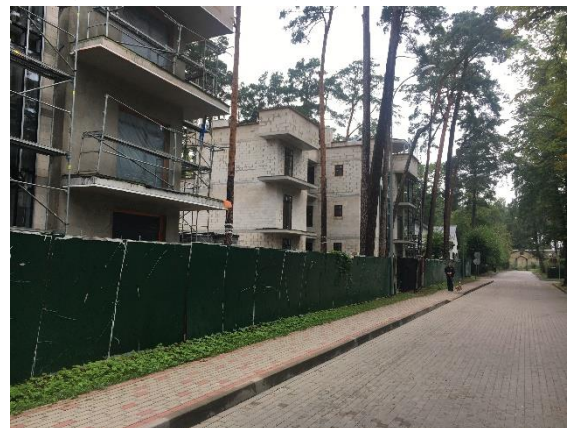
38.attēls. Būvniecības stadijā esošā 3 stāvu apbūve Dzintaru prospektā 12 (18.03.2016. gadā saskaņot būvprojekts).
