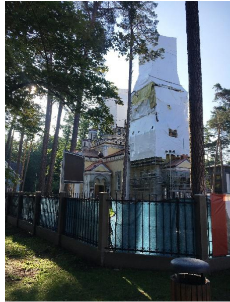
43.attēls. Dzintaru pareizticīgās baznīcas būvniecības process. Zemesgabals Turaidas iela 11.
