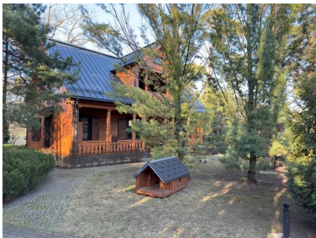
4. attēls. Detālplānojuma teritorijā esošā apbūve, ēka ar kadastra apzīmējumu 1300 009 1502 001
