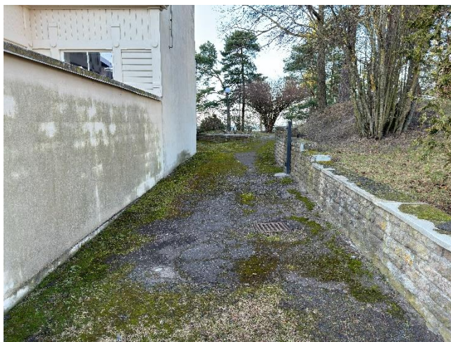
8. attēls. Detālplānojuma teritorijas ziemeļu daļā esošā asfalta seguma josla (skats ziemeļu virzienā)
