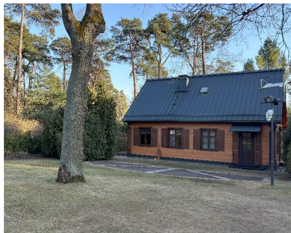
5. attēls. Detālplānojuma teritorijā esošā apbūve, ēka ar kadastra apzīmējumu 1300 009 1502 001
