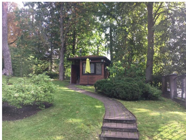
3. attēls. Esošā sarga ēka, būves kadastra apzīmējums 1300 014 0303 002
