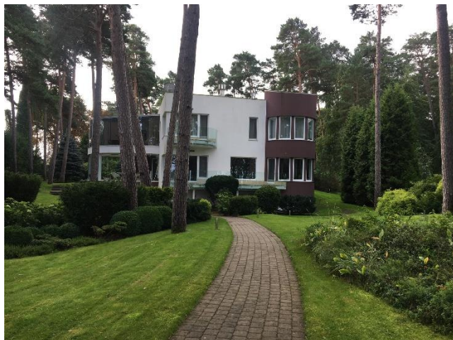
2. attēls. Esošā dzīvojamā ēka, būves kadastra apzīmējums 1300 014 0303 001
