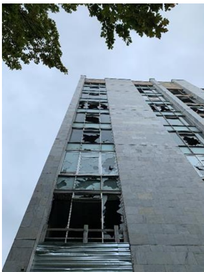
Attēls 17 Viesnīcas fasāde.
