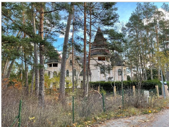
17. attēls. Skats uz zemes vienībā Bulduru prospektā 107 esošo apbūvi. Foto uzņemts 2024. gada novembrī.
