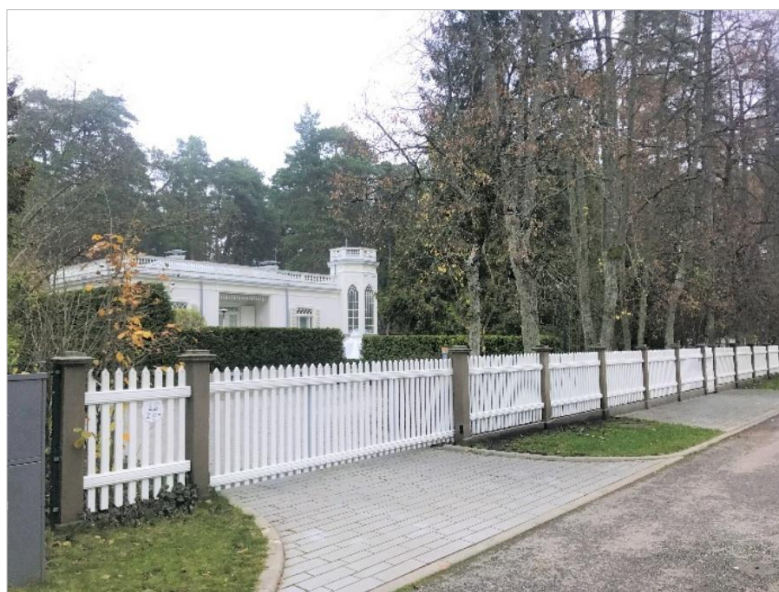
11. attēls. Skats uz zemes vienībā Rotas ielā 3 esošo apbūvi ar kadastra apzīmējumu 1300 004 2302 001. Foto uzņemts 2020. gada oktobrī.
