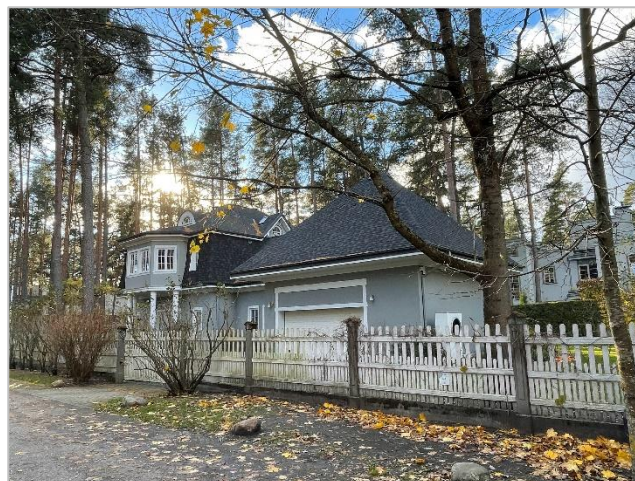
18. attēls. Priekšplānā apbūve zemes vienībā 21. līnijā 4, tālāk apbūve 20. līnijā 3. Foto uzņemts 2024. gada novembrī.
