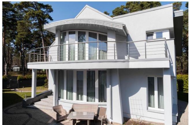
6. attēls. Būvniecības procesā esošā ēka ar kadastra apzīmējumu 1300 012 1201 002
