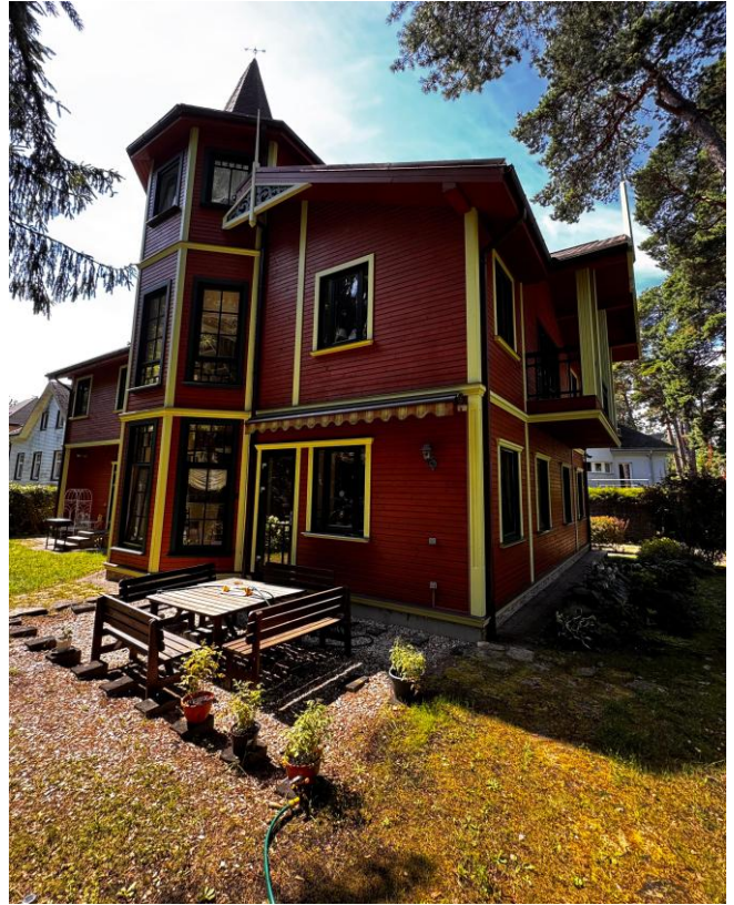
4. attēls. Būvniecības procesā esošā ēka ar kadastra apzīmējumu 1300 012 1201 001
