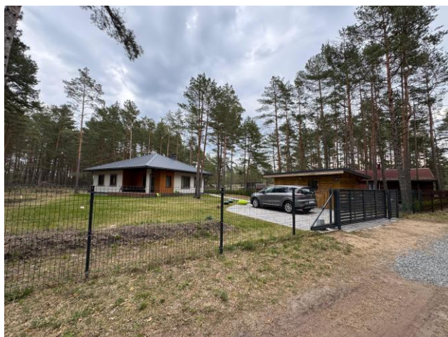
4. attēls. Skats uz Detālplānojuma grozījumu teritorijas centrālo daļu, būvniecības procesā esošo dzīvojamo māju un šķūni (14.04.2025.)
