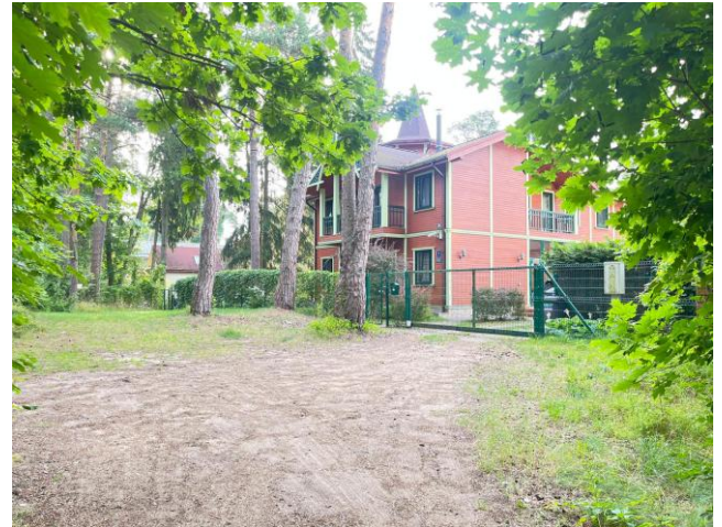
12. attēls. Iebrauktuve pie ēkas ar kadastra apzīmējumu 1300 012 1201 002 no ceļa servitūta teritorijas (28.07.2025.)
