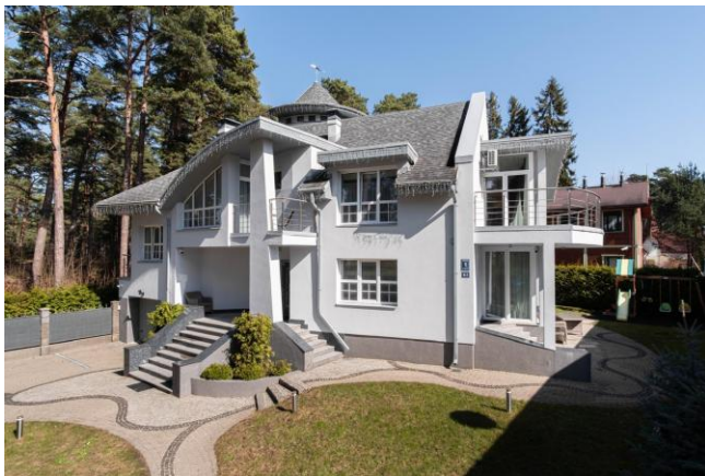
5. attēls. Būvniecības procesā esošā ēka ar kadastra apzīmējumu 1300 012 1201 001
