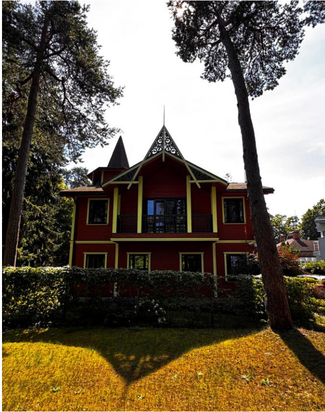
3. attēls. Būvniecības procesā esošā ēka ar kadastra apzīmējumu 1300 012 1201 002
