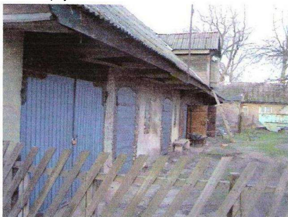
Zemesgabalā esošās palīgēka - kūts.
