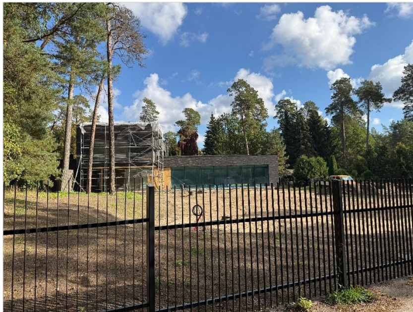
15. attēls. Skats no 27. līnijas uz zemesgabalā Rota ielā 25, Jūrmalā būvniecības stadijā esošo dzīvojamo ēku. Foto uzņemts 07.10.2025.
