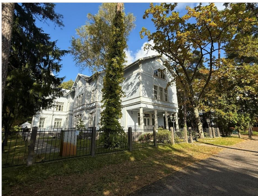
13. attēls. Skats no Rotas ielas uz zemesgabalā Rotas ielā 25, Jūrmalā esošo ēku ar kadastra apzīmējumu 1300 004 2708 00. Foto uzņemts 07.10.2025.
