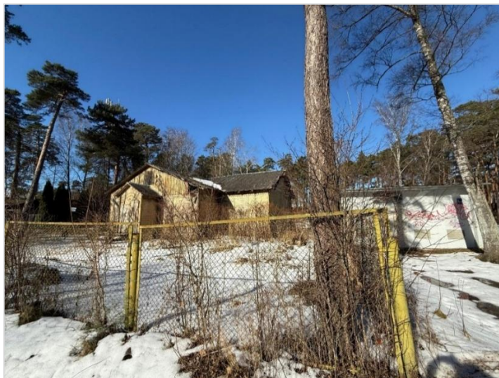
5. attēls. Skats no Smiltenes ielas uz Lokālpārvaldes teritorijā esošo ēku ar kadastra apzīmējumu 1300 009 1902 001 un transformatoru ēku ar kadastra apzīmējumu 1300 009 1902 055. Foto uzņemts 02.03.2026.
