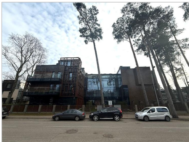
29. attēls. Skats uz Dzintaru prospektā 32 esošu mazstāvu daudzdzīvokļu ēku, kas atrodas 430 metru attālumā no Lokālpārvaldes teritorijas. Foto uzņemts 25.03.2026.
