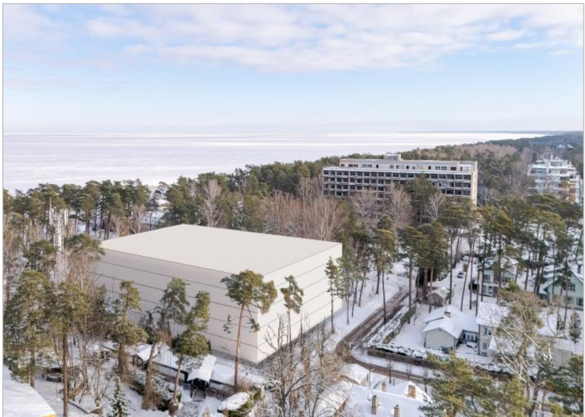
38. attēls. Pašreiz Lokālpārplānojuma teritorijā pieļaujamā, funkcionālajā zonā Jauktas centra apbūves teritorija JC10 noteiktā maksimālā apbūves blīvuma (30 %) un maksimālās apbūves intensitātes (150 %) attēlojums Lokālpārplānojuma teritorijā. Attēlu izstrādāja arhitektūras un dizaina birojs “Open Architecture Design: OAD”
