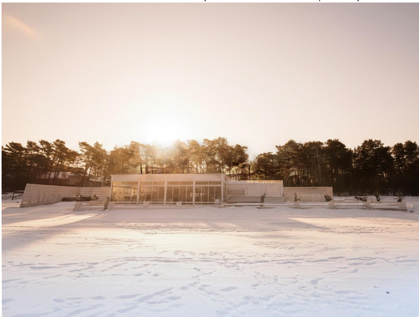
2. attēls . Skats no pludmales uz plānoto objektu Smiltenes ielā 1.
